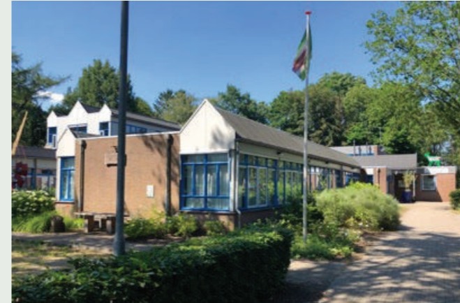
Zicht op de lokalen en entree
