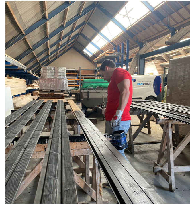
De starters helpen de aannemer met schilderwerk zodat de kosten gedrukt kunnen worden.
