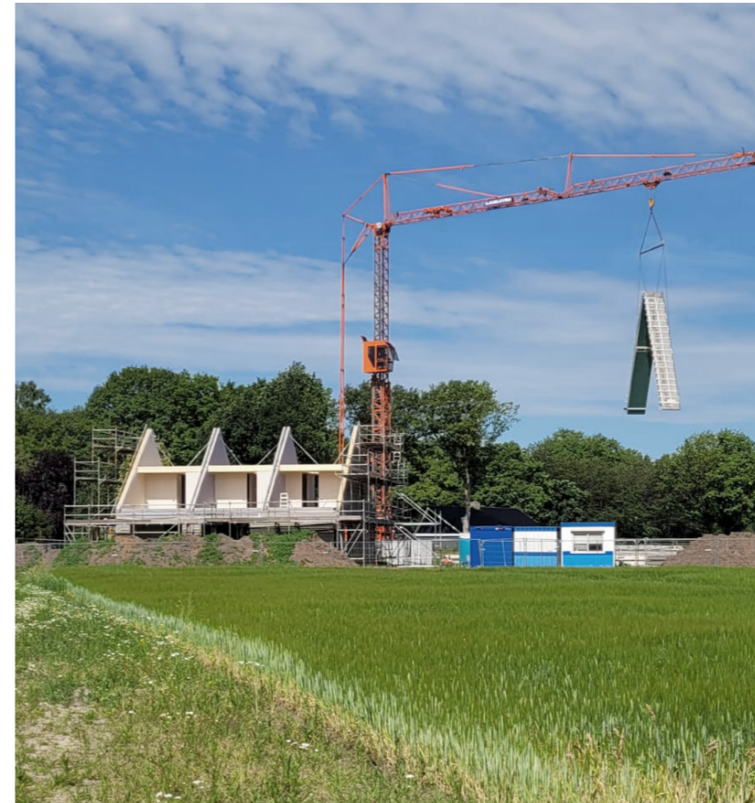
De woningen zijn volledig opgebouwd met prefab houtbouw elementen.
