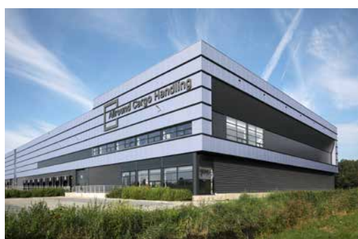
Allround cargo Handling, Ridderkerk (bron: FALK® Bouwsystemen)
